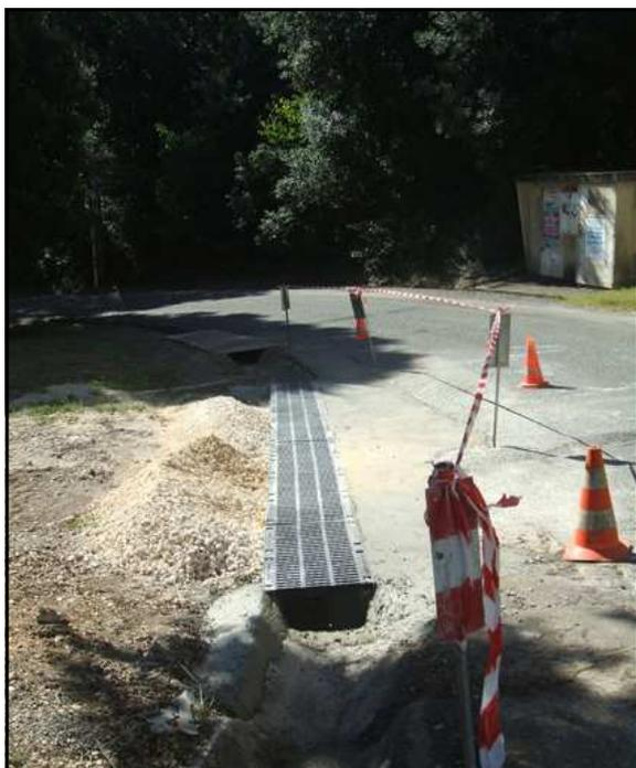
Ces derniers jours, l'équipe technique a réalisé un passage busé avec grille pour canaliser l'eau pluviale et permettre l'accès correct aux garages de la rue Gagarine. Elle a aussi profité des journées ensoleillées pour faire de la peinture routière
