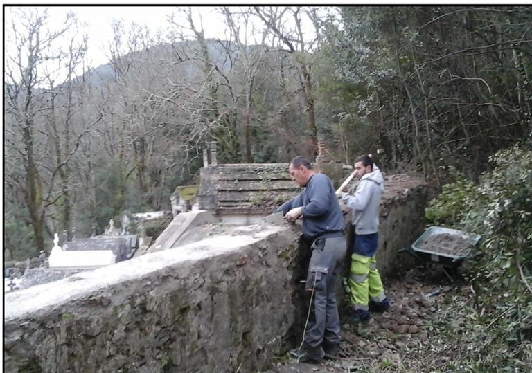
Les services techniques municipaux viennent de réaliser le nettoyage et la reprise de l'arasement des murs d'enceinte du cimetière du Puech.
